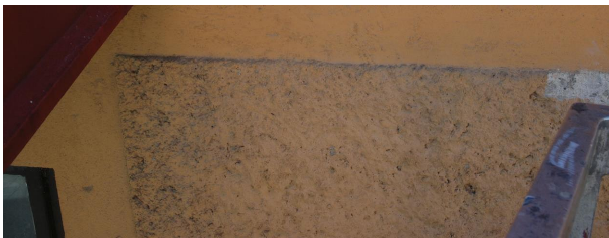
Na fotografiích je patrný rozdíl mezi finálním vzhledem strukturovaných omítek „nahazovaných – hrubých“ /nahore/ a strukturovaných omítek s „utaženým – zahlazeným“ povrchem – na následující straně.
