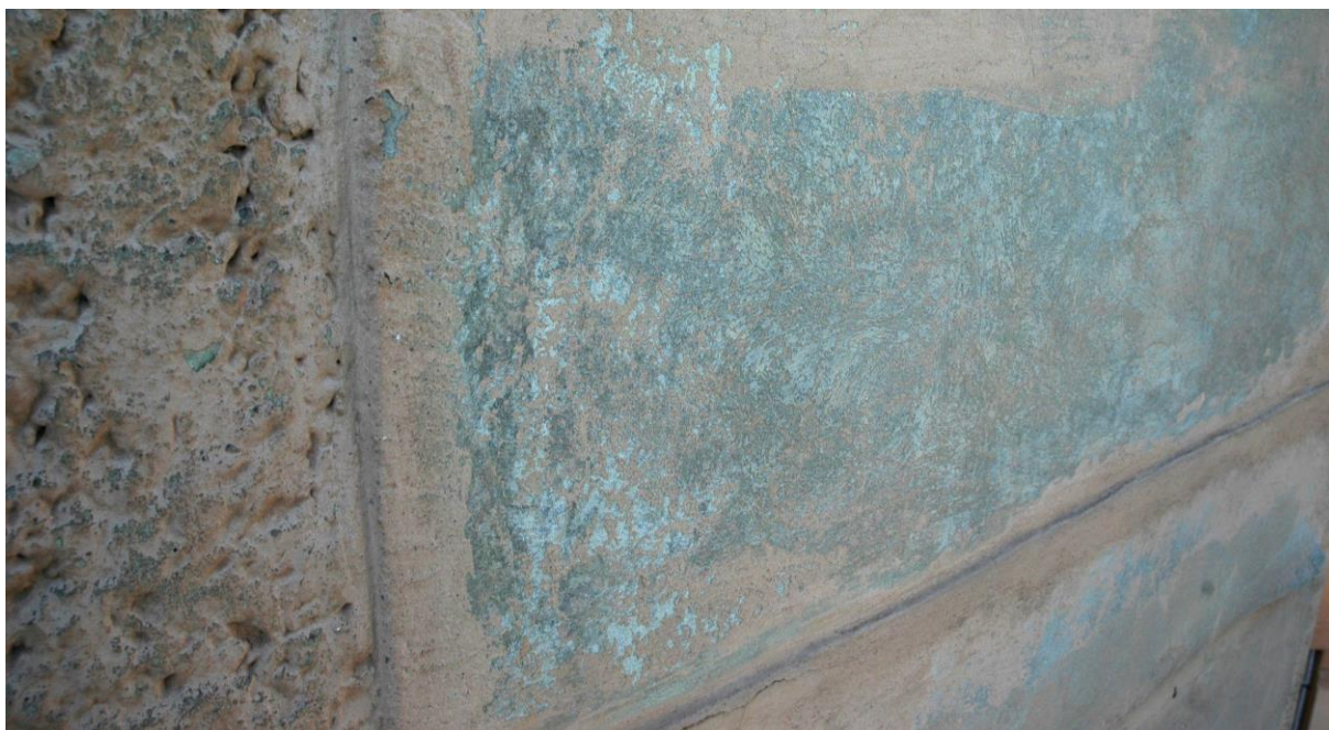
Na fotografii jsou zřetelné stopy krouživého pohybu tvrdého hladítka.
