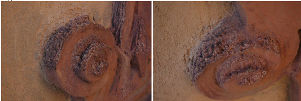
Na fotografiích je vidět hlubkové narušení povrchu dekorativního prvku, charakteristické pro sádkový materiál.
