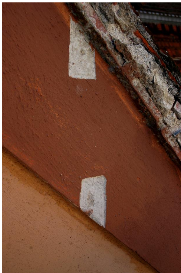
Zjednodušená profilace lemu štítu provedená z nové cementové omítky
