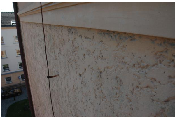
Celkový pohled na plochu fasády opatřenou „strukturovanou a utaženou“ omítkou
