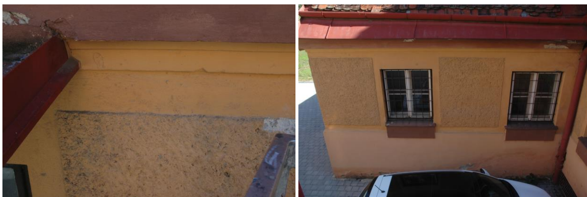
Strukturované omítky na jednopodlažním jižním křídle.
