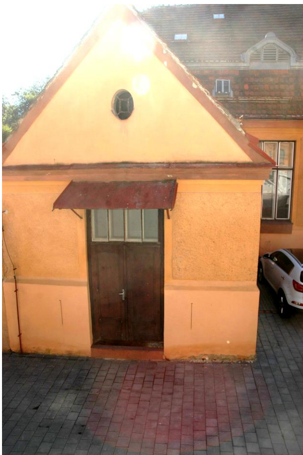
Zjednodušená profilace lemu štítu provedená z nové cementové omítky
